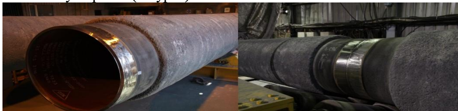
2-сурет - Бетонды қаптамамен құбыр сыртын жабу
