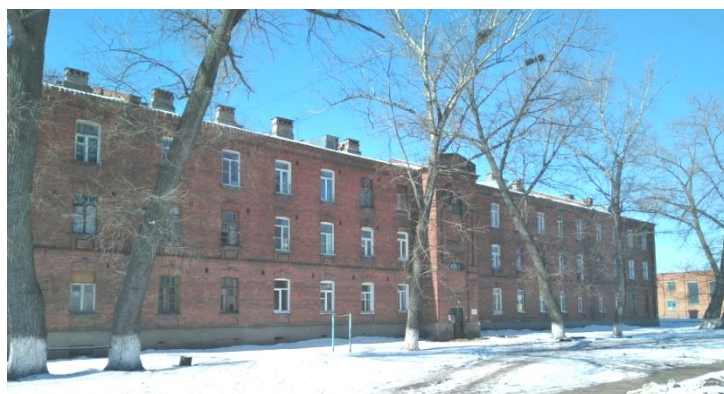
Рисунок 2. Южный (главный) фасад здания
