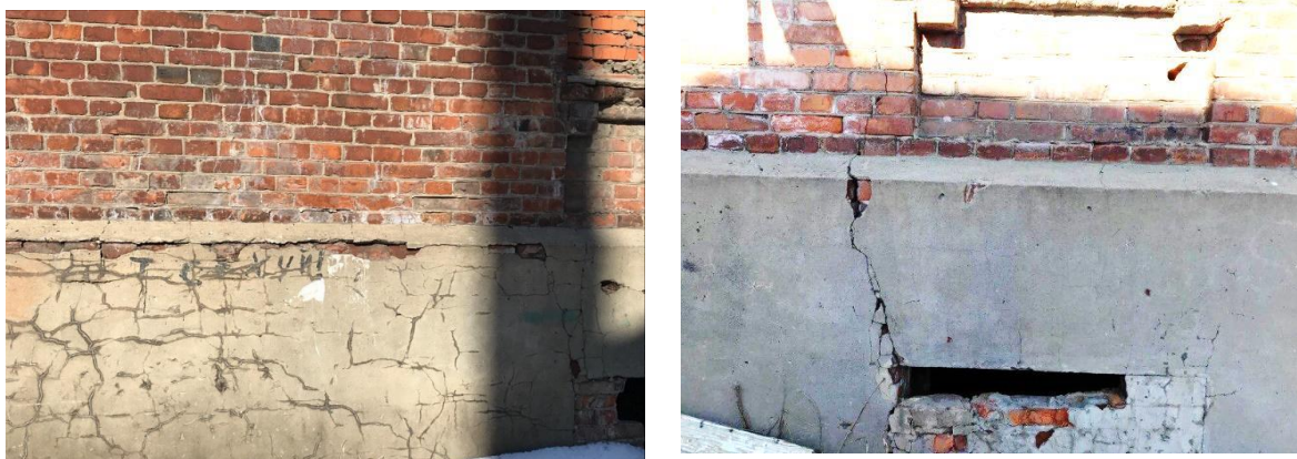
Рисунок 4. Вид цоколя на северной стороне фасада
