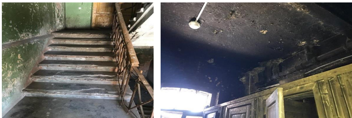
Рисунок 8. Внешний вид штукатурки в санузле после пожара
